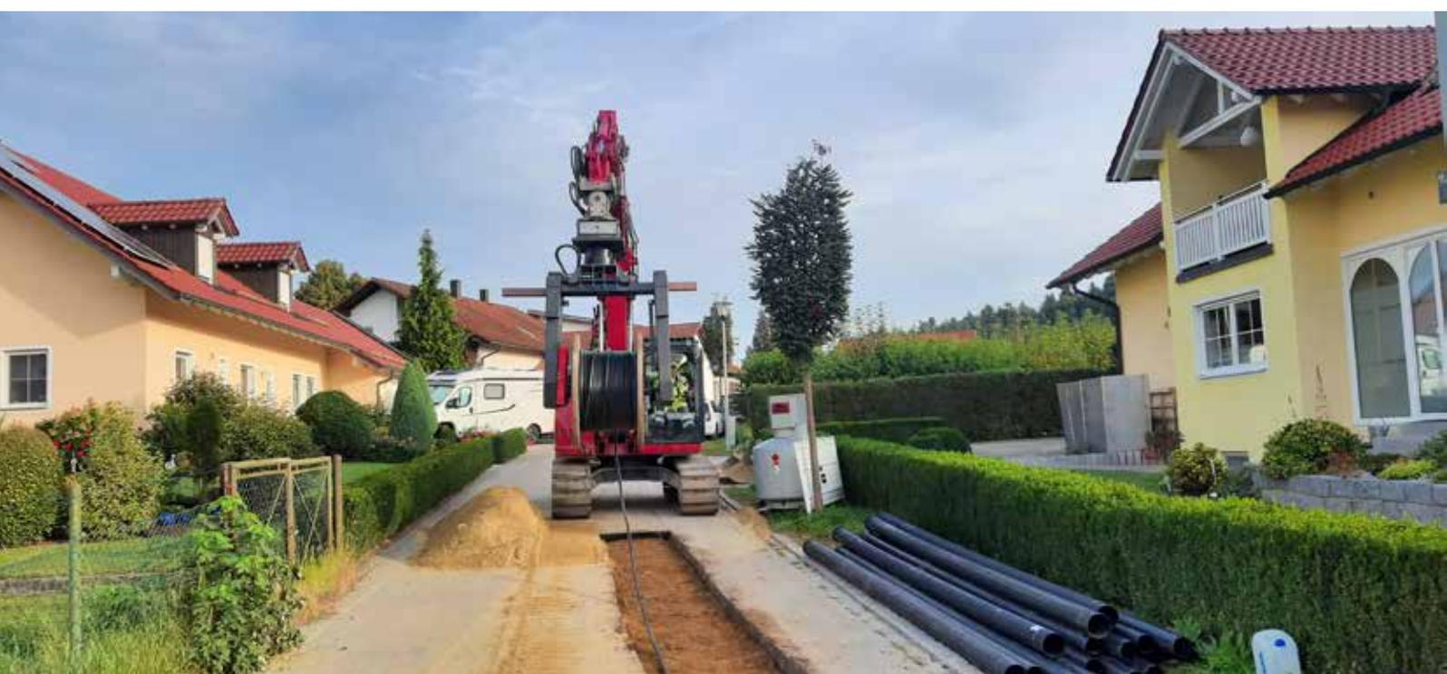
Das CRL System ist dafür konzipiert, sämtliche Kabeltrommeln-Materialien mit verschiedenen Aufnahmen schonend zu händeln.
